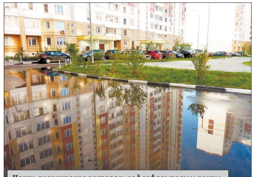
Часть ливнеотоков оказалась под асфальтовым покрытием. На их месте образуются практически невысыхающие лужи.
